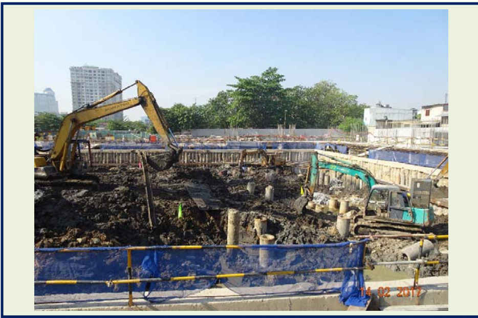
ĐÀO ĐẤT ZONE 6 – GD2
