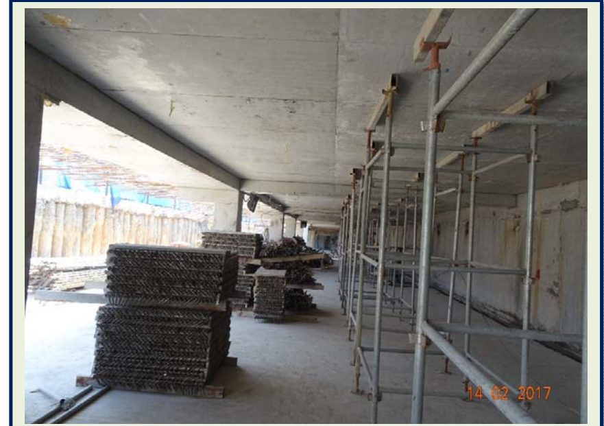
BÊ TÔNG SÀN TẦNG 1
