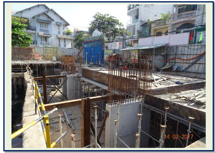
THÁO CỐP PHA DẦM SÀN TẦNG 1
